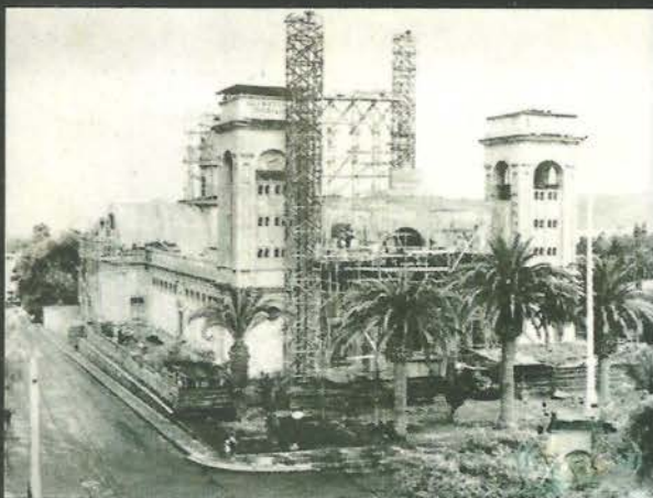
"Trabajos de construcción de la Catedral de Tacna a inicios de la década de 1950"
